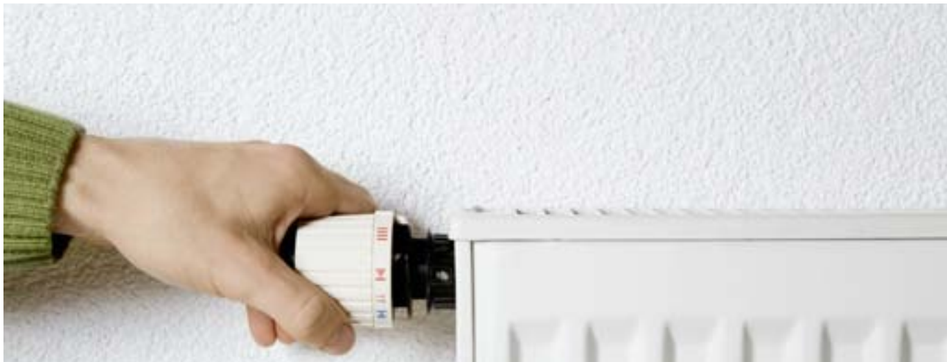
Eine Heizung kann nur so sparsam sein, wie das Gebäude es zulässt. Aber es kommt auch auf Pumpe und Regelung an – und auf den klugen Kopf, der die Thermostate richtig einstellt
