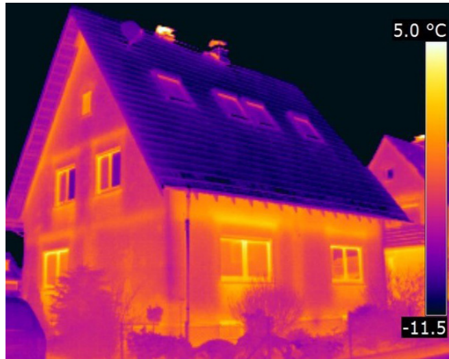
Geschossdecken und Rollladenkästen
