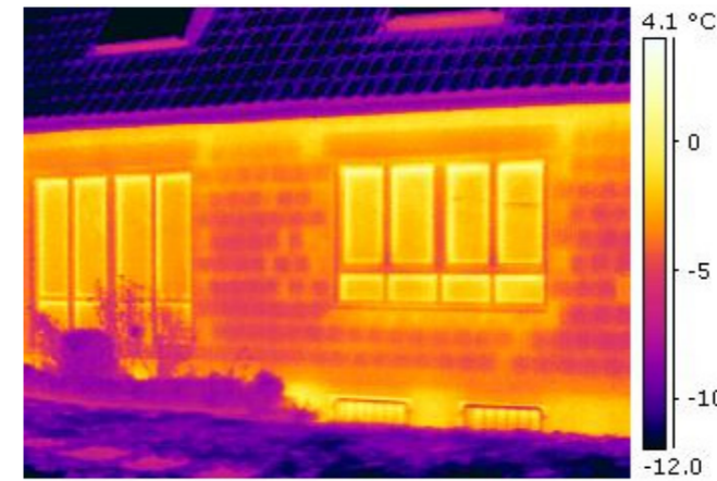
Thermografie einer monolithischen Außenwand
