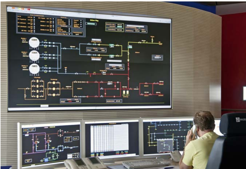
Eine große Rückprojektionswand bildet in der Netzleitstelle das Versorgungsnetz ab. Aachens Lebensadern werden hier rund um die Uhr überwacht.
