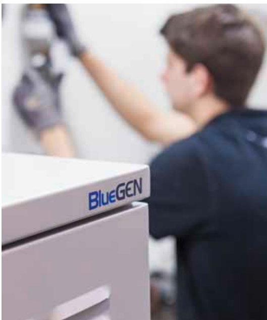
Der BlueGEN im Keller von Familie Pieren liefert ganzjährig Strom und übernimmt die Warmwasserversorgung im Haus.
