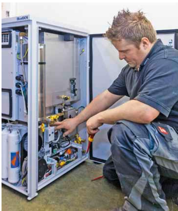
Heizungsbauer Holger Hötz von der Firma Hohnen weiß, wie man eine Brennstoffzelle installiert.
