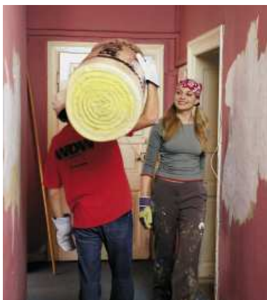
Eine energetische Sanierung macht Altbauten fit für die Zukunft
