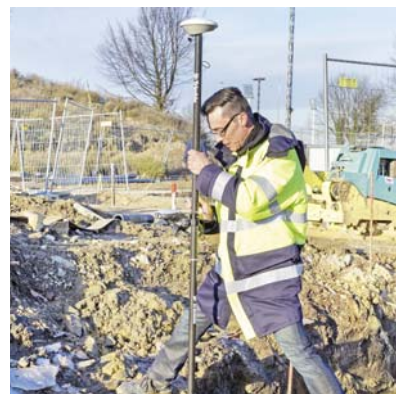
Alexander Dolch markiert die neu verlegten Versorgungsleitungen, die sein GPS-Gerät via Satellit ortet und aufzeichnet.
