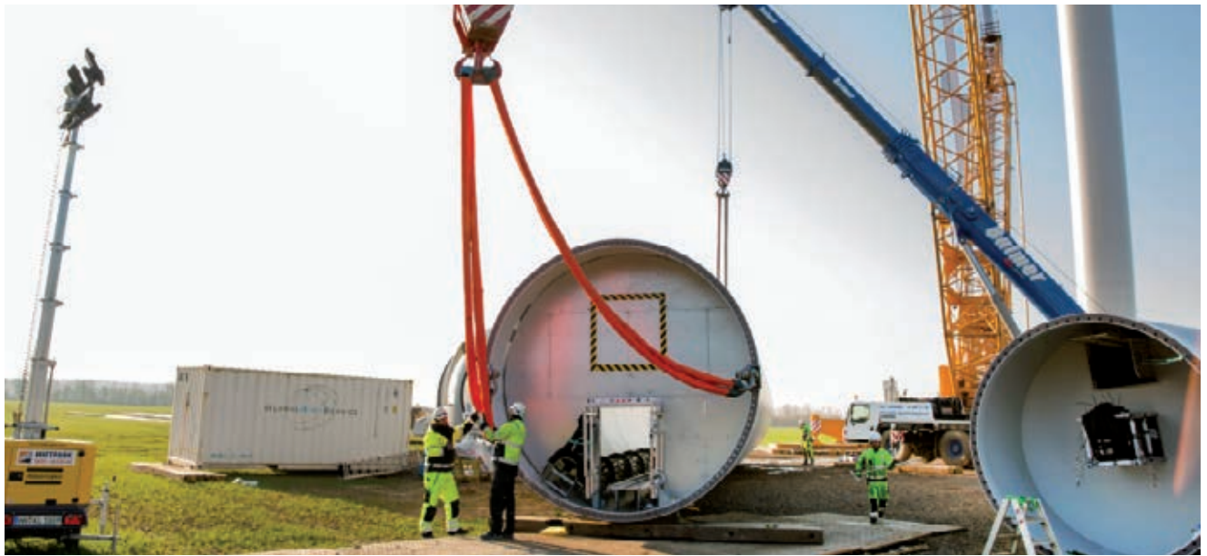
Hoch hinaus: Vorbereitung für den Turmbau im Windpark Bergheim
