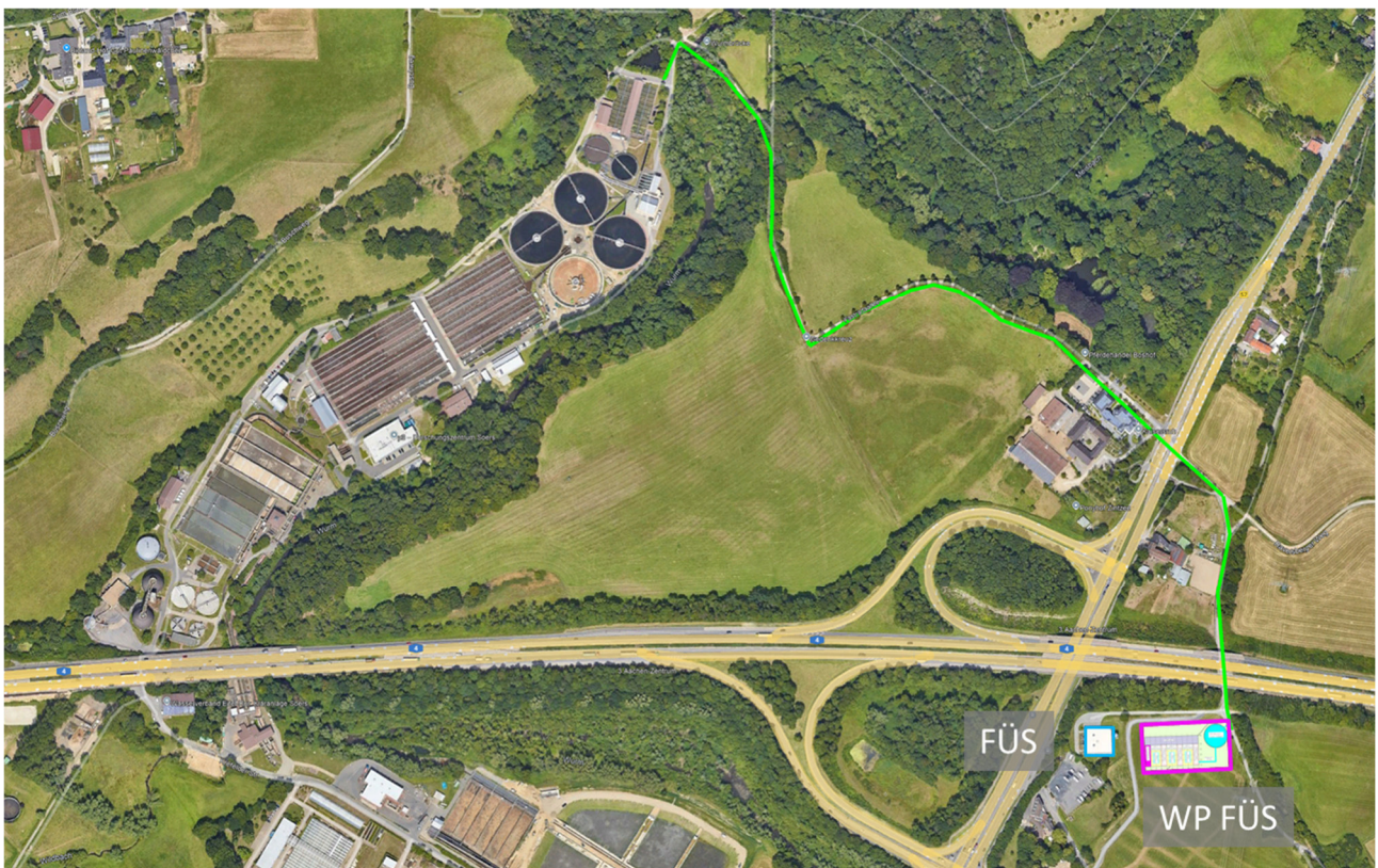
Abbildung 23: Luftbild geplante Reinwassertrasse zwischen Kläranlage Soers und FÜS
